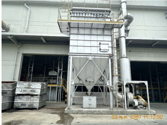
รูปถ่ายที่ 3.2-1 : ระบบดักฝุ่นแบบถ่วงกรง
