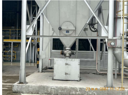
รูปถ่ายที่ 3.2-28 : ถังเหล็กเก็บฝุ่นอะลูมิเนียม จากระบบดักฝุ่นแบบลูกกรอก
