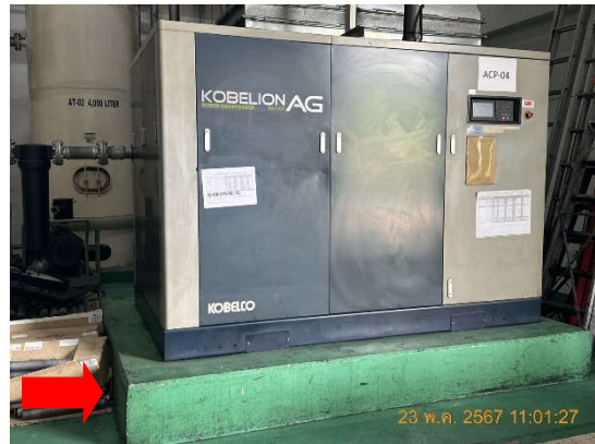
รูปถ่ายที่ 3.2-3 : เครื่องจักรติดตั้งบนฐานซับเสียงเพื่อลดเสียงดัง
