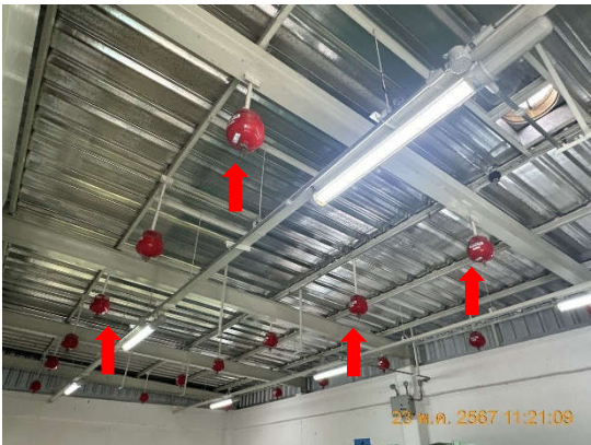
รูปถ่ายที่ 3.2-49 : ระบบดับเพลิง บริเวณอาคารเก็บสารเคมี
