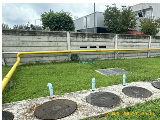
รูปถ่ายที่ 3.2-51 : ป้ายแสดงทิศทางการหมุนวาล์ว และแสดงทิศทางการไหลในท่อขนส่ง
