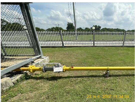
รูปถ่ายที่ 3.2-51 : ป้ายแสดงทิศทางการหมุนวาล์ว และแสดงทิศทางการไหลในท่อขนส่ง
