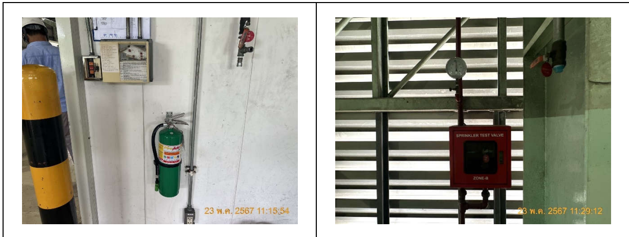
รูปถ่ายที่ 3.2-55 (ต่อ) : อุปกรณ์ป้องกันอันตรายและระงับอัคคีภัย (อุปกรณ์ดับเพลิง)
